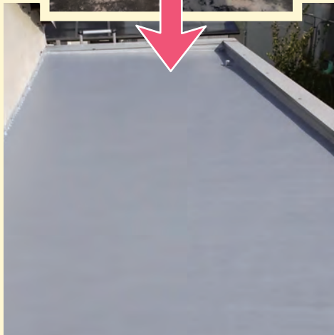
(有)Y様陸屋根 ウレタン防水で修繕
