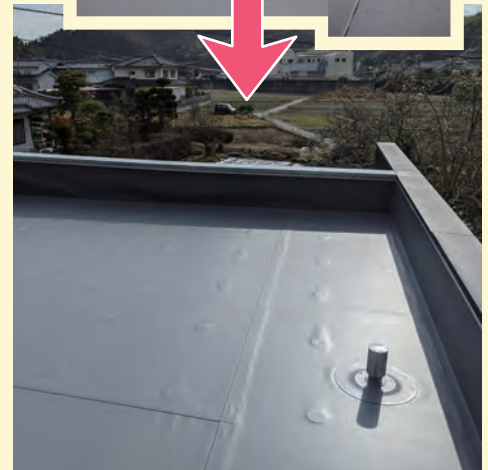
K様邸陸屋根 シート防水で修繕
