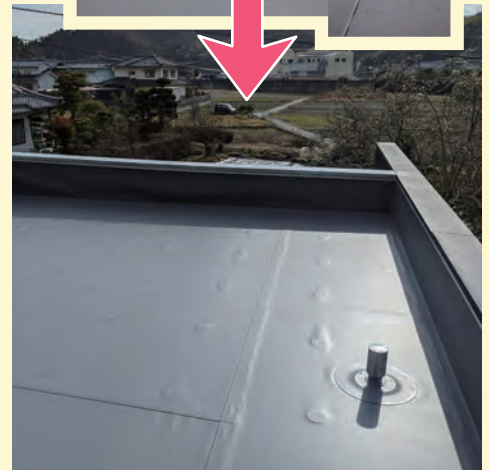
K様邸陸屋根 シート防水で修繕
