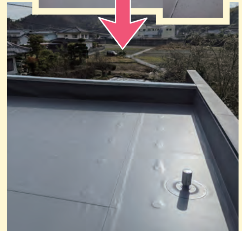
K様邸陸屋根 シート防水で修繕
