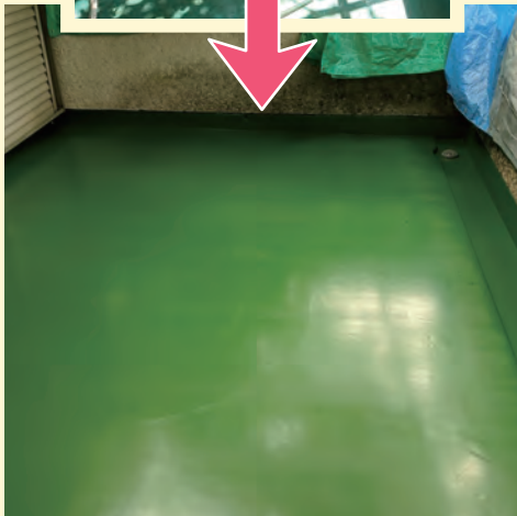
N様邸のベランダ シート防水で修繕 ウレタン防水で修繕
