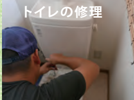
トイレの修理
