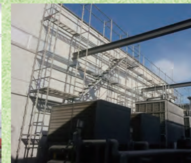
メディアプレス瀬戸内様 外壁修繕工事
