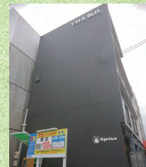
宝町ビル 外観リニューアル工事
