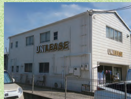
南ユニリース広島様 外壁修繕工事・看板工事
