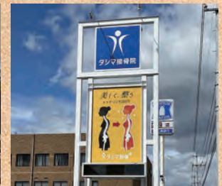
これから照明工事です!
