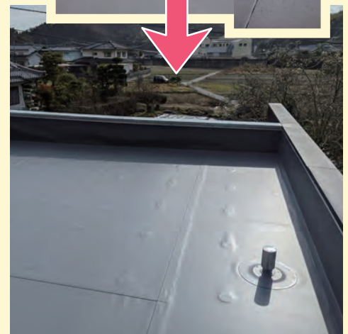
K様邸陸屋根 シート防水で修繕
