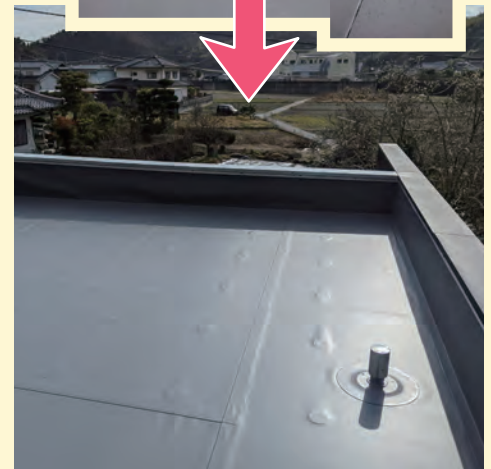
K様邸陸屋根 シート防水で修繕
