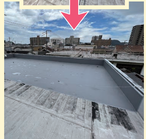
Y様陸屋根防水部分修繕 雨漏りの原因であるところを 徹底的に防水修繕
