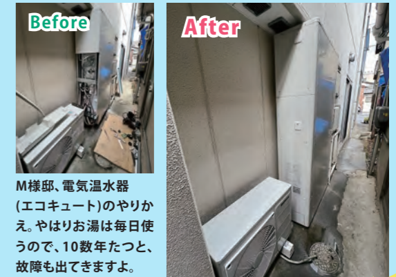
M様邸、電気温水器(エコキュート)のやりかえ。やはりお湯は毎日使うので、10数年たつと、故障も出てきますよ。 半日でパバッと入れ替え完了!
