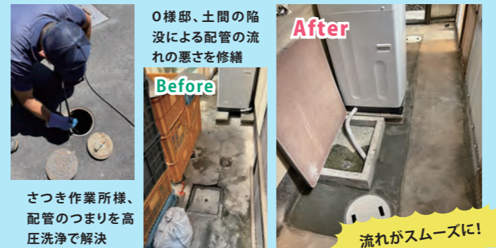
さつき作業所様、配管のつまりを高圧洗浄で解決 流れがスムーズに!
