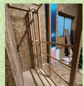
倉庫に仮設のWCを作ってくれました。これで壁紙の練習ができますわ!腕を磨いてくださいね!WCの壁紙工事は学びが盛り沢山
