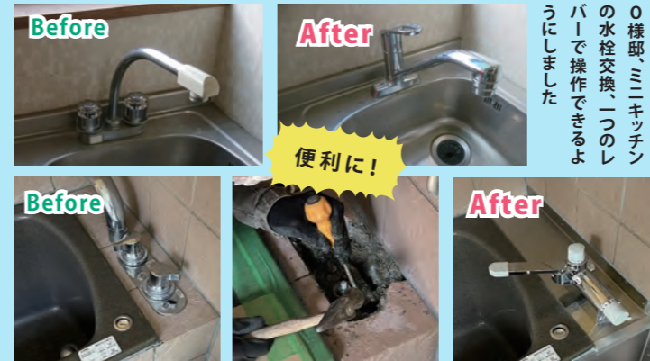
サポート&ケアセンターフレンズ様 お風呂の水栓交換 メンテナンスしやすいように、タイル⇒ステンレスで、ひと工夫 修理しやすく!
