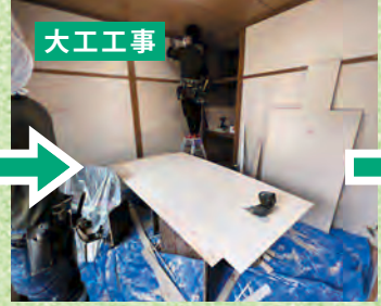
大工工事 砂壁の上に直接壁紙を貼ることは不可能。まず、大工さんに、砂壁部分に、ベニア板を打ち付けてもらいました。
