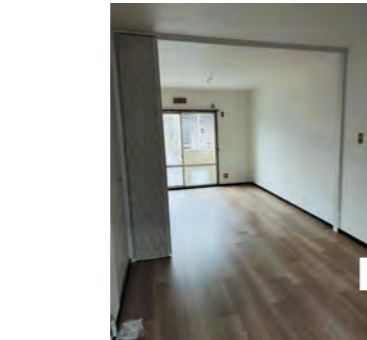
向島町某アパート広いLDKをアコーディオンカーテンで間仕切れるようにしました。効率！&目隠しにもなりますね！
